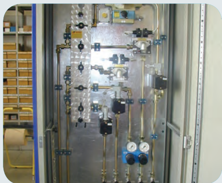
Armadio pneumatico di comando e controllo freni.
